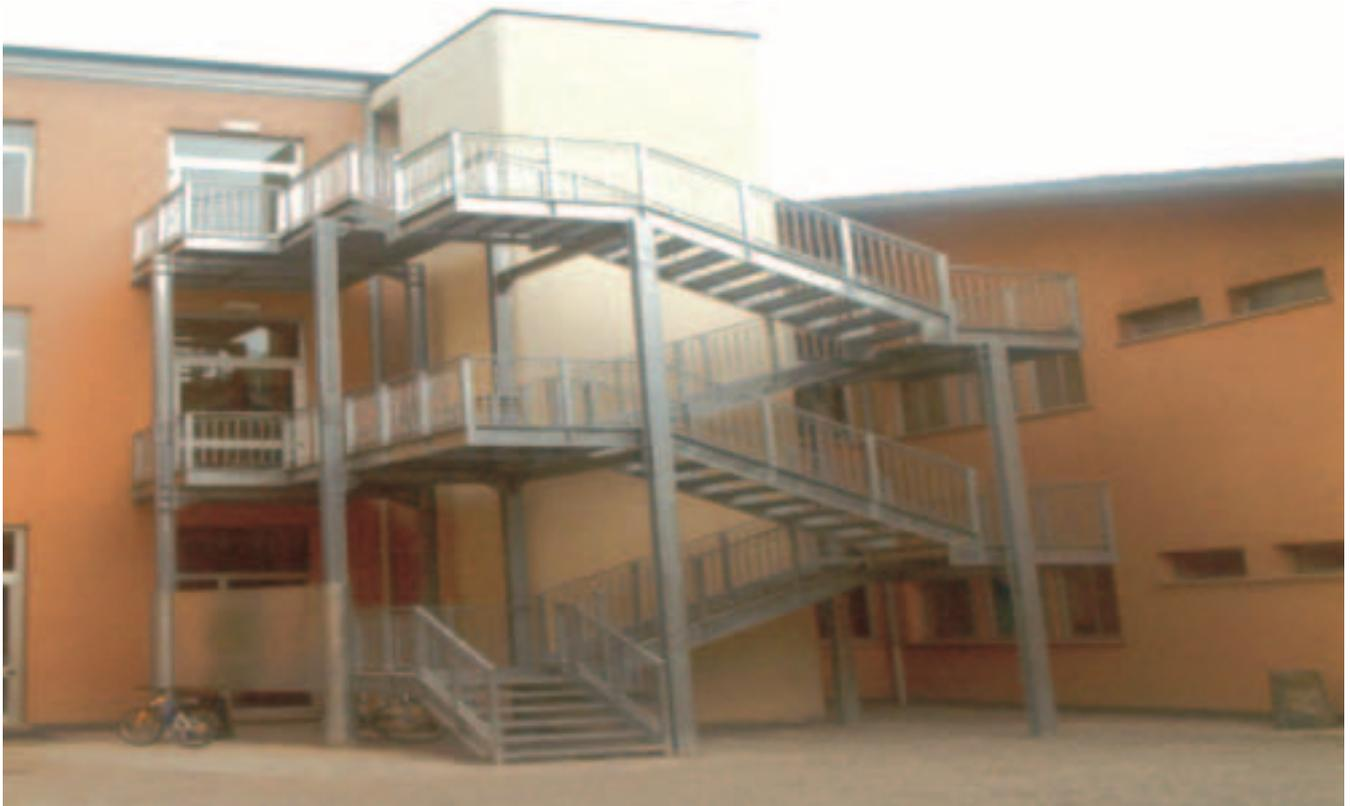
*Scala di sicurezza esterna in acciaio. La scala è stata realizzata a servizio di un edificio scolastico degli anni '60 che era privo di adeguate vie di fuga ed uscite di emergenza. Un intervento semplice, per garantire un percorso di evacuazione non troppo lungo. Notare il vano ascensore realizzato all'esterno dell'edificio.*
