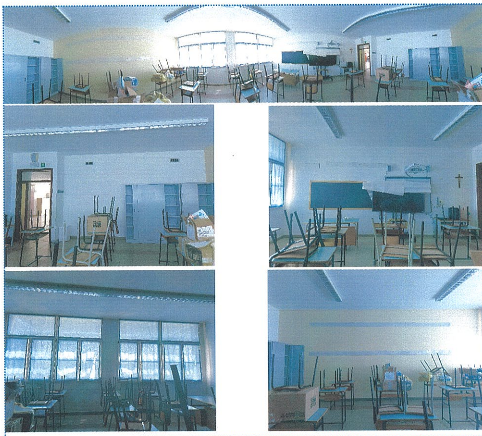
Figura 21 Aula n° 98-Scuola Primaria-Casalmaggiore
