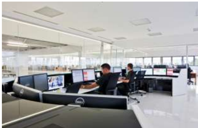
Figura 6: Immagine del Network Operations Center
