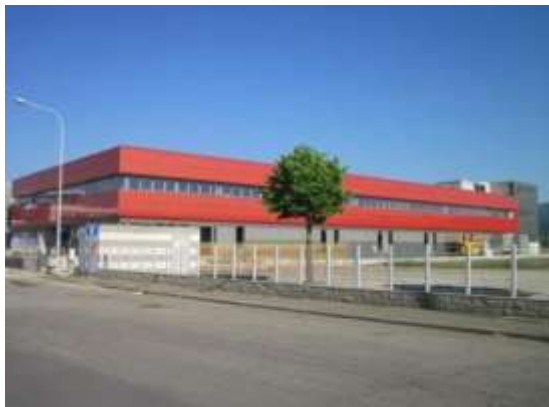
Figura 5: Immagine esterna del Datacenter
