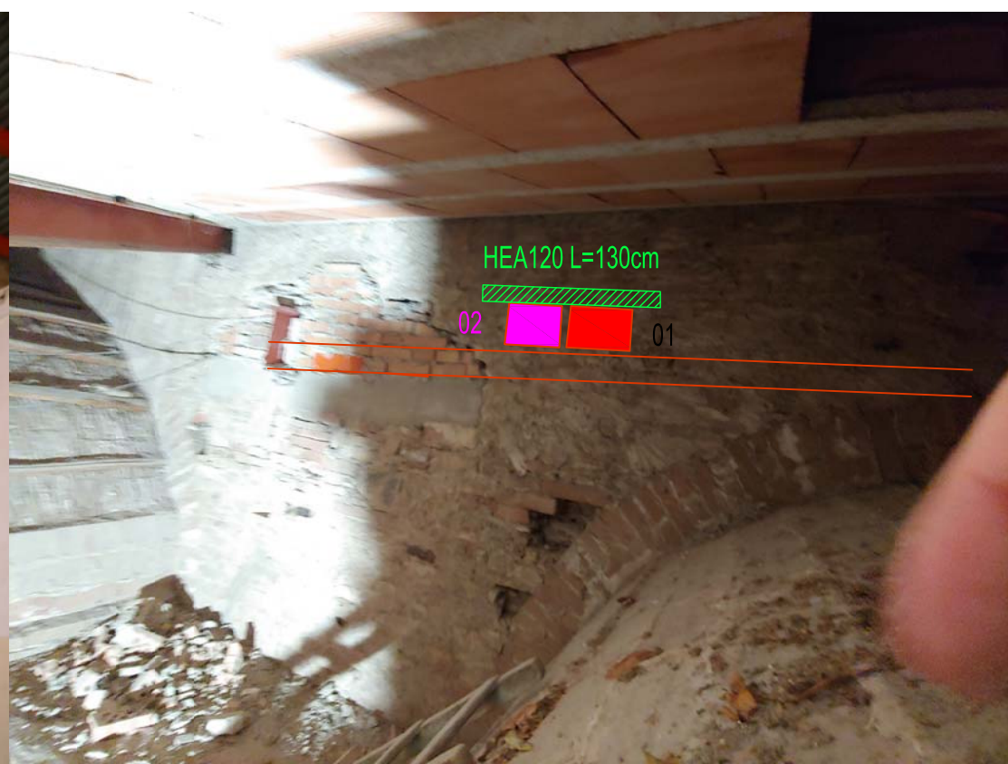
FOROMETRIA lato corridoio passaggio tubazioni
