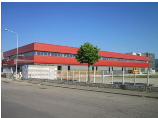
Figura 5: Immagine esterna del Datacenter
