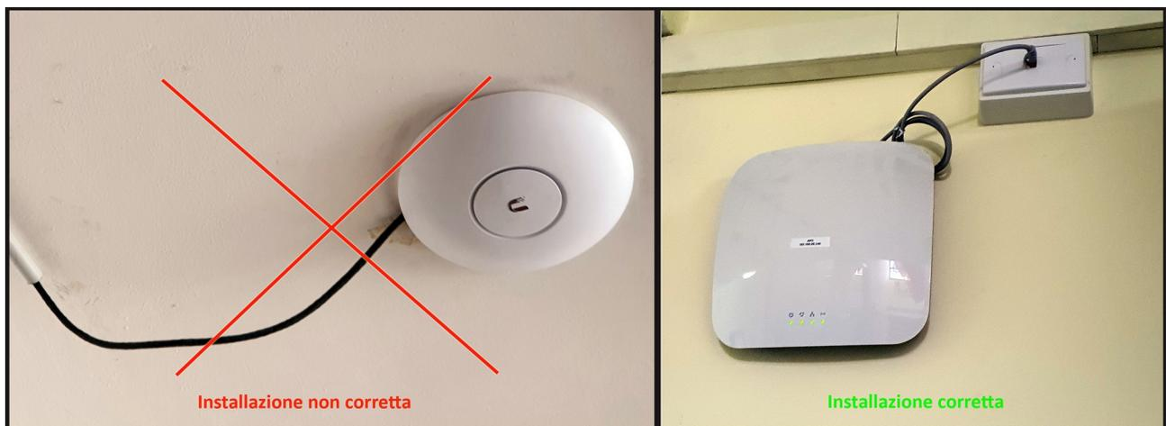
Figura 10 - Installazione corretta dell'Access Point
