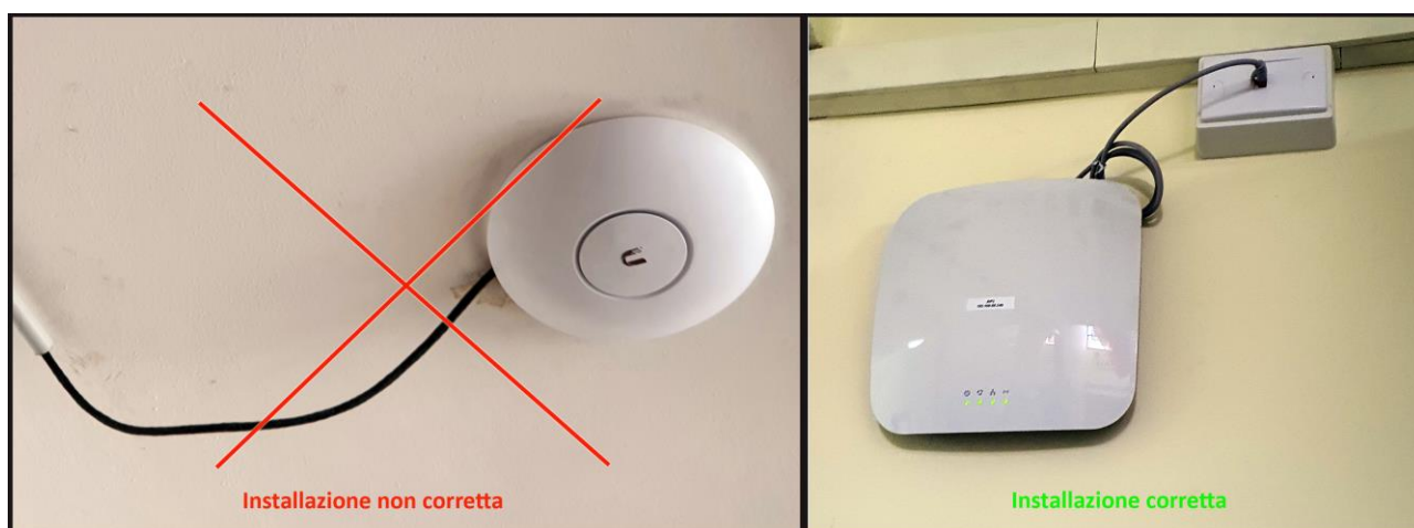
Figura 10 – Installazione corretta dell'Access Point
