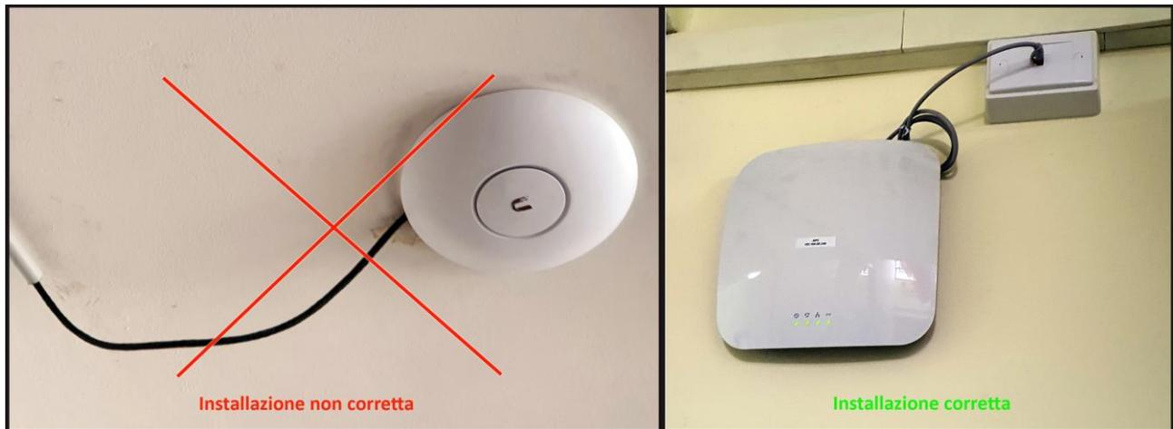
Figura 10 – Installazione corretta dell'Access Point
