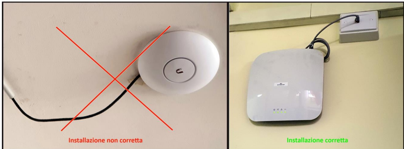
Figura 10 – Installazione corretta dell'Access Point
