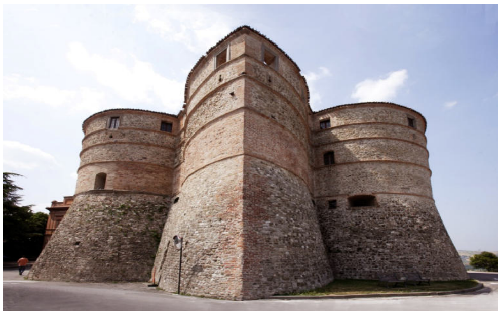
Il puntone carenato, lato sud
