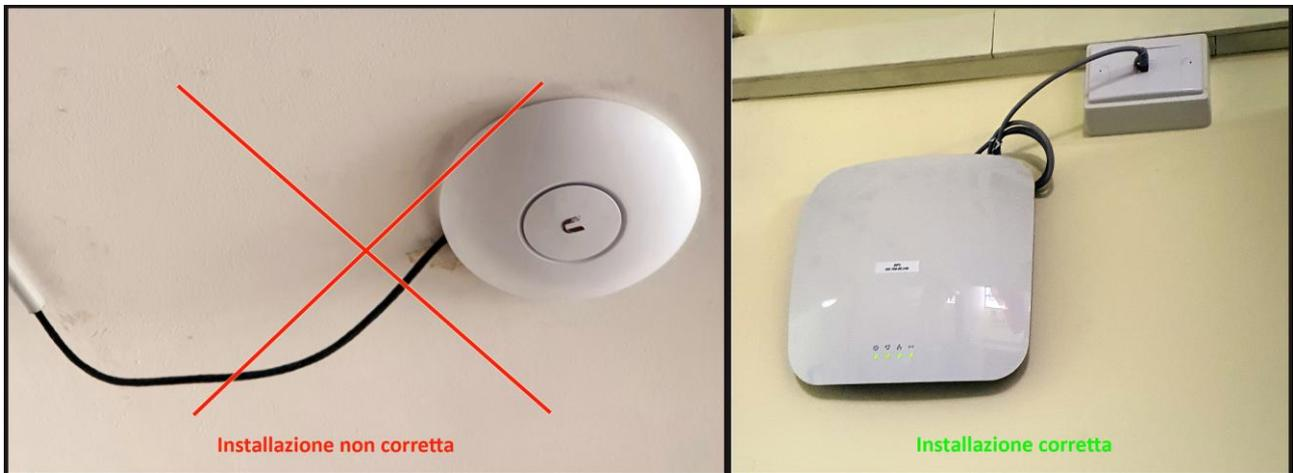
Figura 10 – Installazione corretta dell'Access Point
