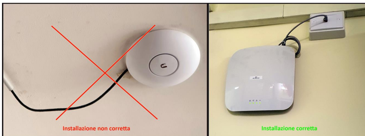
Figura 10 – Installazione corretta dell'Access Point
