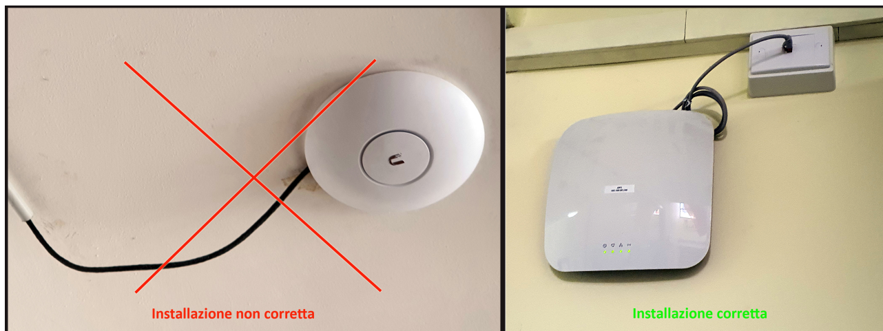
Figura 10 – Installazione corretta dell'Access Point
