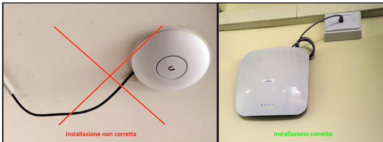
Figura 10 – Installazione corretta dell'Access Point
