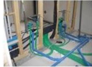
La funzione dell'impianto idrico è quella di distribuire l'acqua calda e fredda ad uso sanitario a ciascun punto di erogazione.
