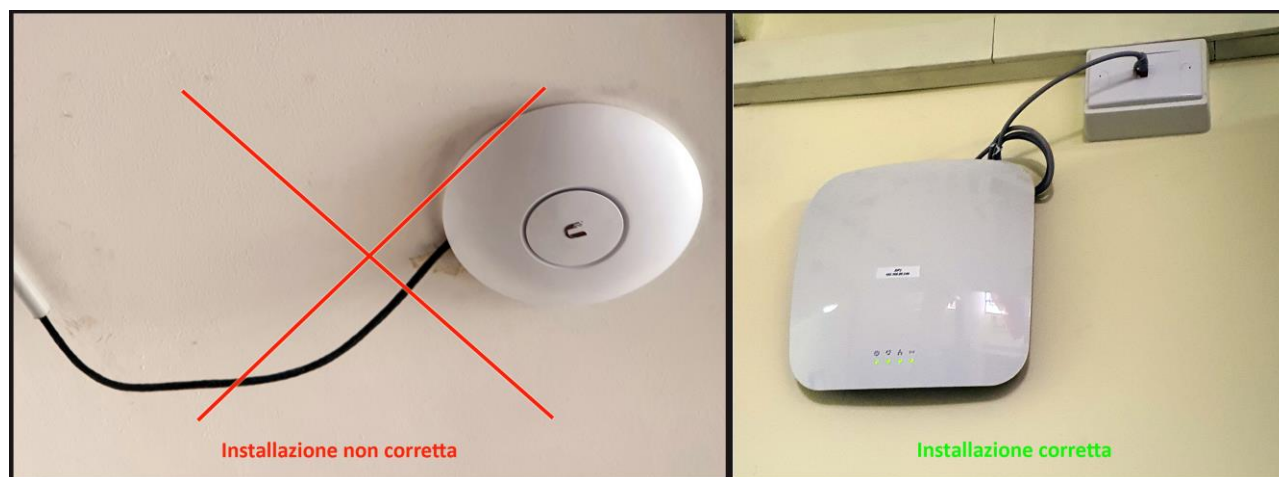
Figura 10 – Installazione corretta dell'Access Point
